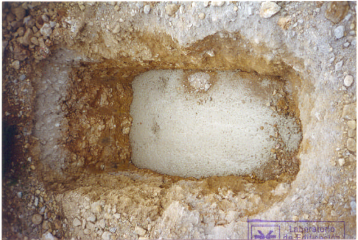
Fotografía 2 Final de hormigonado
