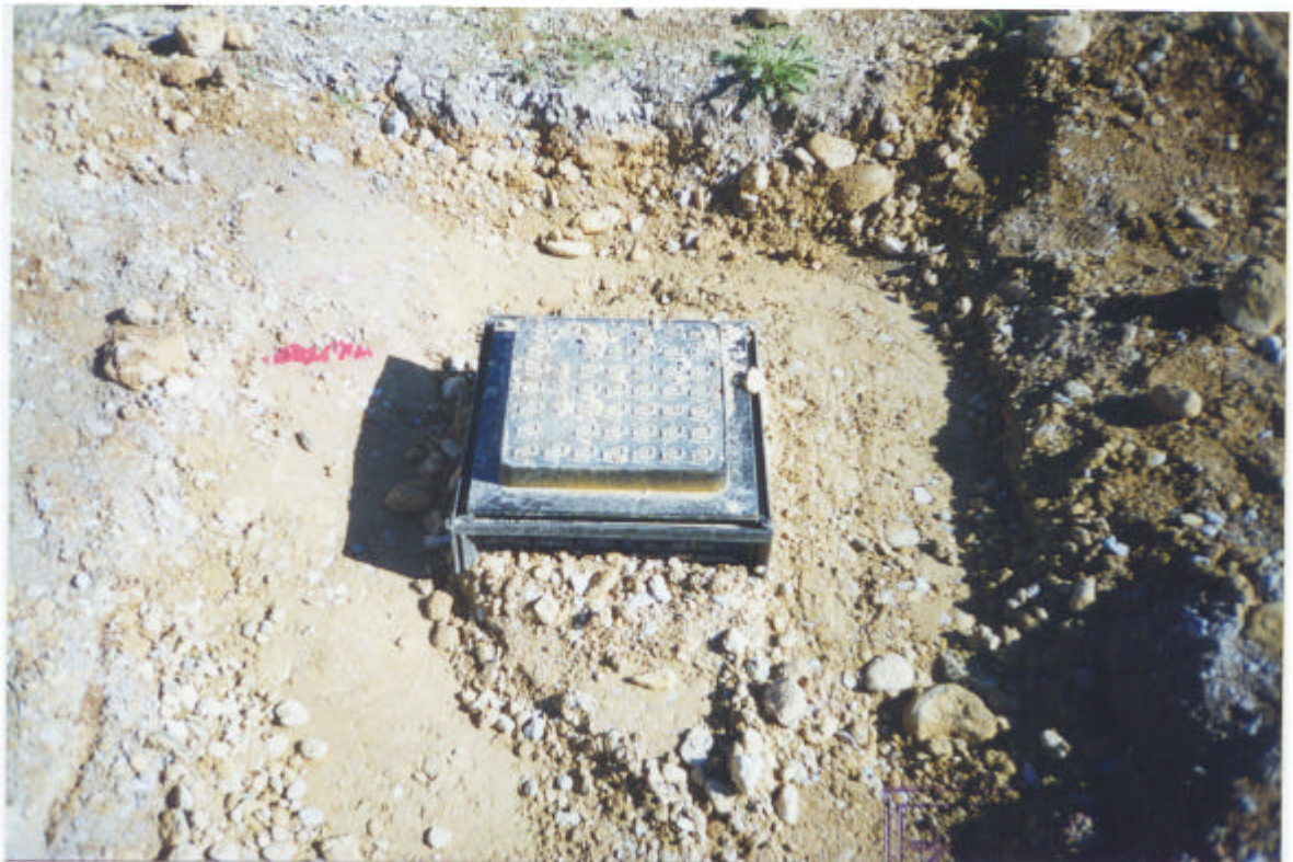
Fotografía 3 Arqueta envuelta en zahorra semicompactada
