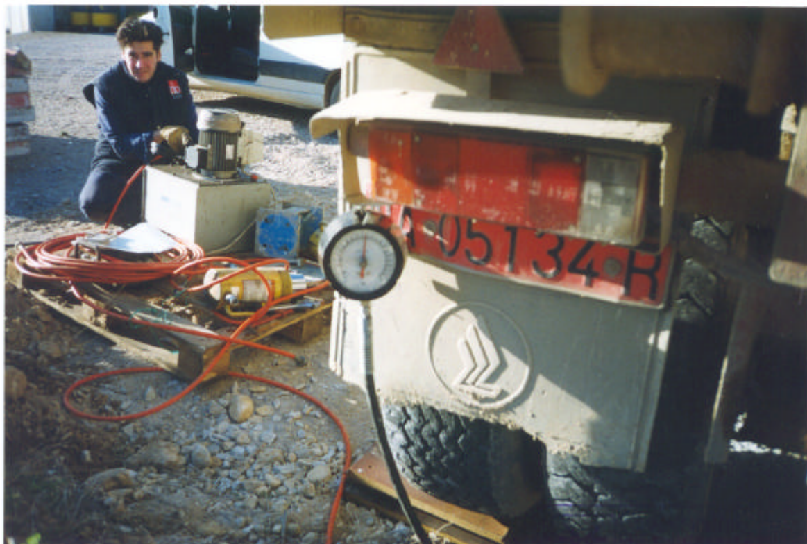
Fotografía 5 Dispositivo de aplicación de la carga
