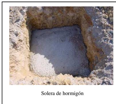
*A la hora de realizar la excavación se deberá tener en cuenta la profundidad de la arqueta y la altura del marco..*
