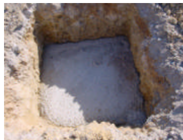
Solera de hormigón
