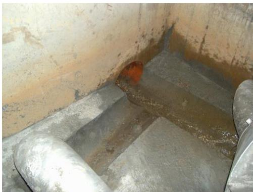
Figura 8: Conducto de salida y medias cañas a la salida del vortex y del by-pass
