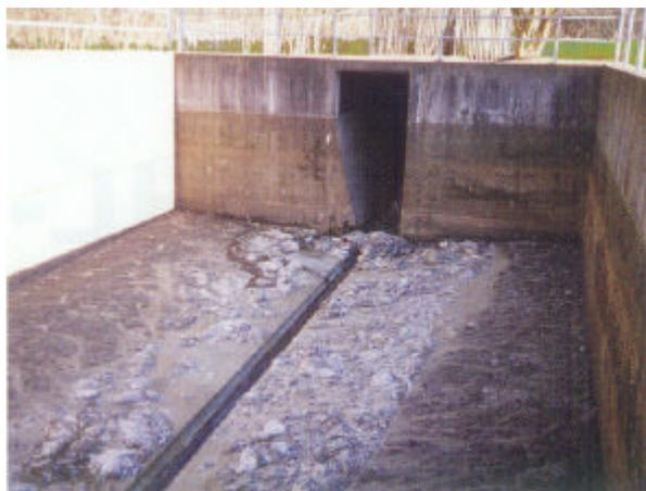
Fig 1. Sedimentación en Tanque de Tormentas
