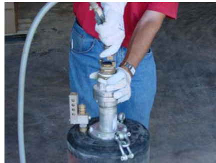
Conexión de manguera de by-pass (Para llenado de aire a la tubería)
