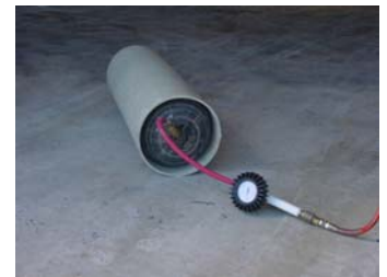
Inflado del Balón obturador (ciego) con el hinchador con manómetro.
