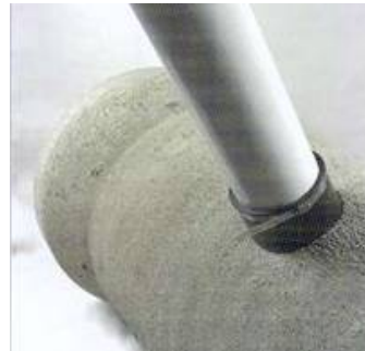
Tubo lateral totalmente instalado
