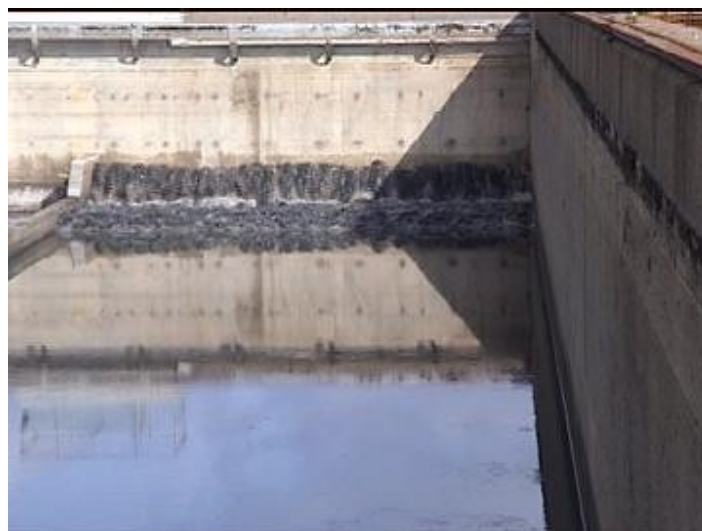
Figura 1: Ola de limpieza generada por la descarga del sistema de vacío.
