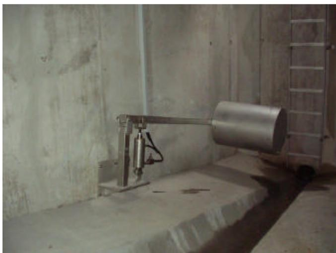
**Vista del flotador de control**
