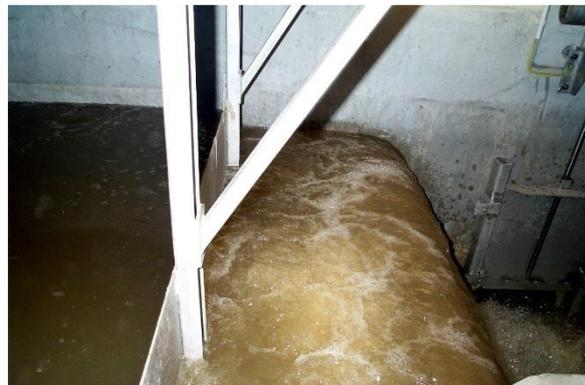
Tamiz en funcionamiento. El nivel de agua es tal que es necesario aliviar a través de la rejilla al medio receptor.
