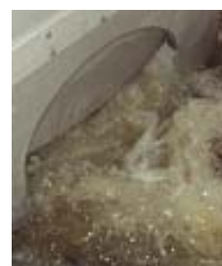
Caudal de agua en la salida
