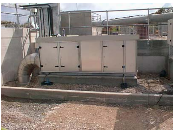
Tanque de tormentas.
