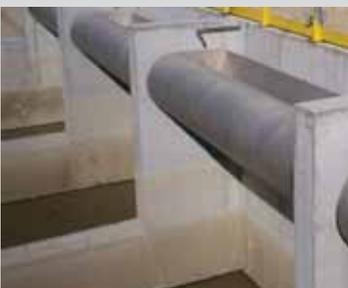
Die Wasserretention in den verschiedenen Kammern eines Beckens führt letztendlich zu Ablagerungen in den Kammern. Durch Einsatz von Reinigungssystemen lässt sich die Reinigung von Hand und damit eine unangenehme und gefährliche Arbeit vermeiden.
