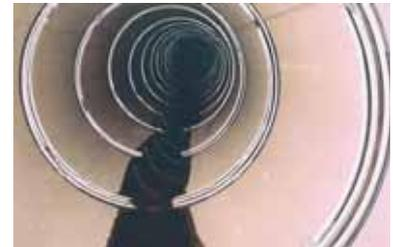
**Kor-N-Seal (flexible Verbindungen Rohr-Schacht)**
