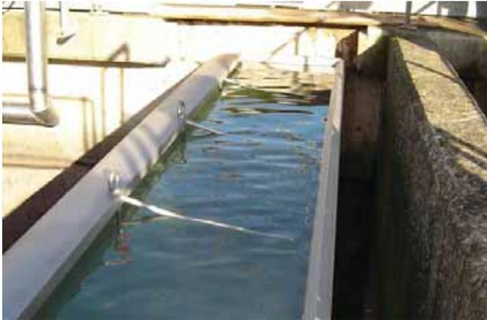
Sobald sein Wasseraufnahmevermögen laut Dimensionierung erreicht ist, verlagert sich sein Schwerpunkt und er kippt. Auf diese Weise entsteht eine Welle, die alle Ablagerungen zum niedrigsten Punkt im Becken schwemmt, von wo aus sie über das Regelventil der Kläranlage zugeführt werden.
