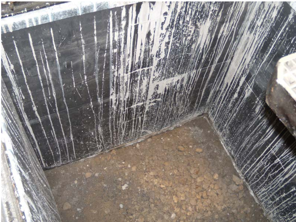
Interior arqueta tras aplicar la carga de 41.800 kp.
