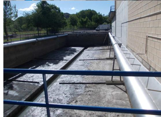
La prueba realizada con la sedimentación acumulada en el tanque tras varios eventos de lluvia resulto completamente satisfactoria limpiando toda la sedimentación de la solera con un único volteo.
