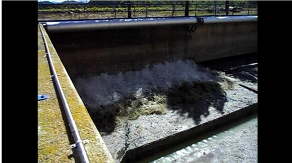
Esta solución ha sido también implantada en también en tanques cuyo sistema existente tenía un elevado consumo energético y unos elevados costes de mantenimiento, el sistema utilizado en el tanque de la derecha fue sustituido satisfactoriamente por los limpiadores basculantes con soportes en A, cuya altura se definió para que la limpieza fuese efectiva y quedasen los limpiadores fuera del agua dada la poca profundidad del tanque y la longitud existente.
